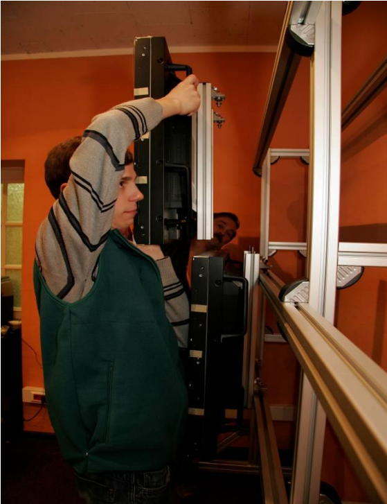
Установка верхней панели
