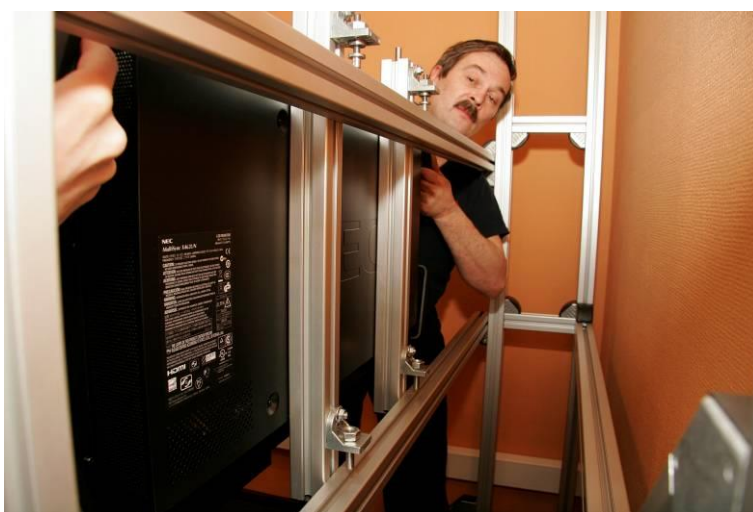
Установка нижней панели
