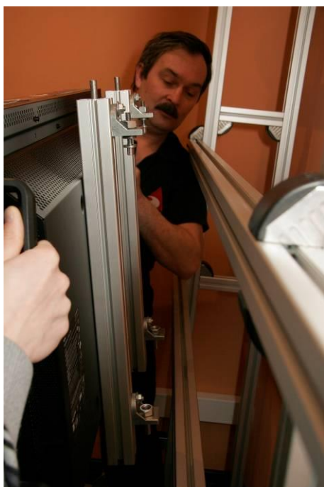
Установка нижней панели
