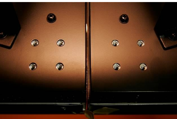
Установка соединительной пластины
